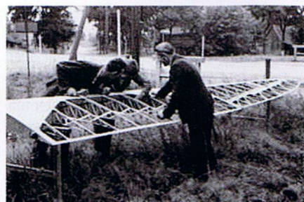
Baby-Fläche im Rohbau Frühjahr 1952
